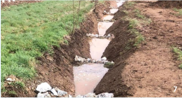
Vue d'un fossé à redents
